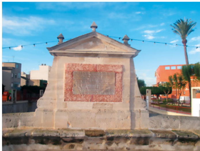
Casalicio trapezoidal construido en el centro del costado derecho del puente en dirección aguas arriba. Conserva un paramento de mármol veteado y una gran lápida de jaspe negro con inscripción conmemorativa de la terminación del puente en 1790.
